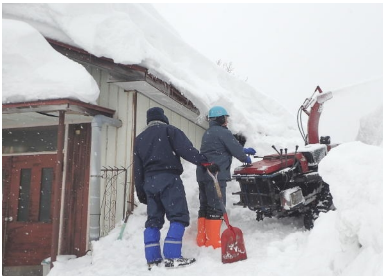
屋根まで繋がった雪を大型除雪機で飛ばす。
